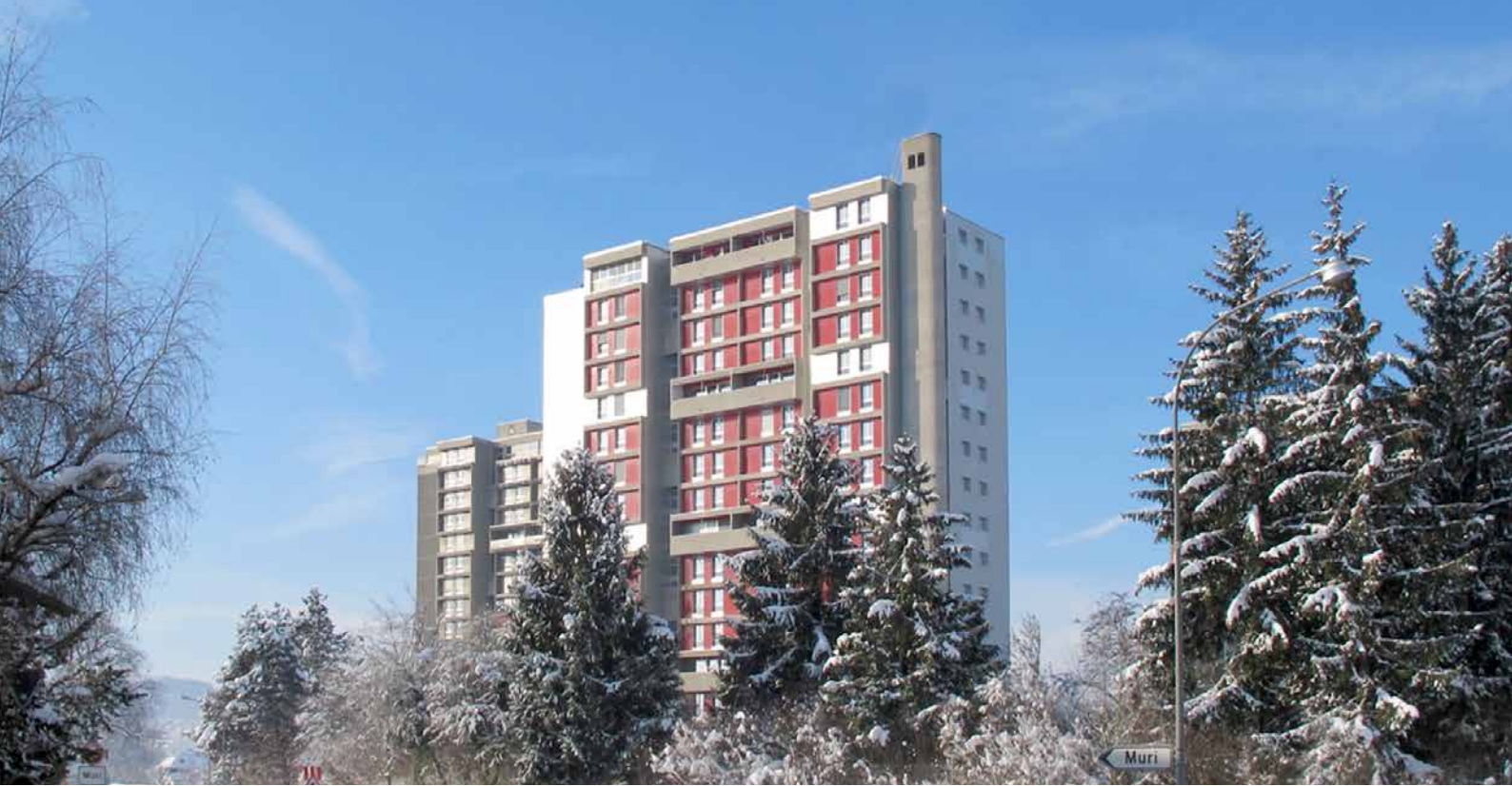
Sanierung eines Mehrfamilienhauses in Muri bei Bern
